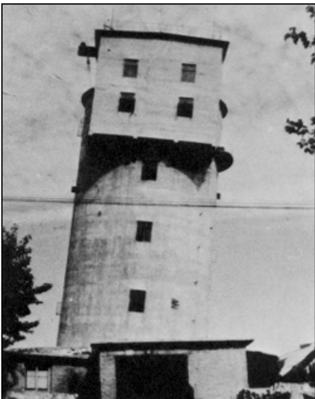
FIGURE 2 TILTED VENTILATION TOWER AT THE TANGSHAN COAL MINE FROM THE GREAT TANGSHAN EARTHQUAKE (CALIFORNIA INSTITUTE OF TECHNOLOGY, 2002)
